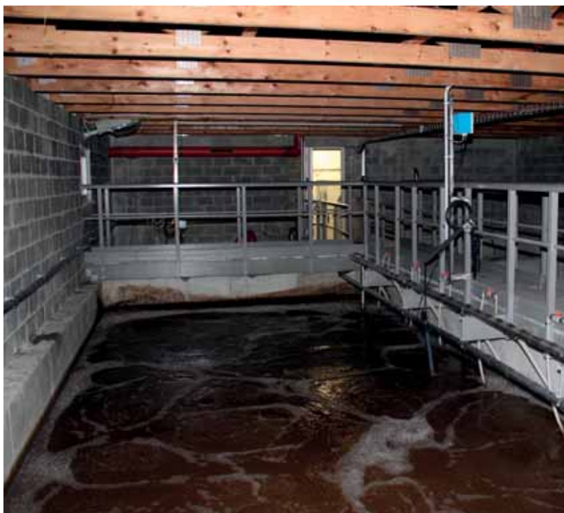
Infrastruktura je v majetku obce a byla vybudována díky prostředkům Evropské unie.
